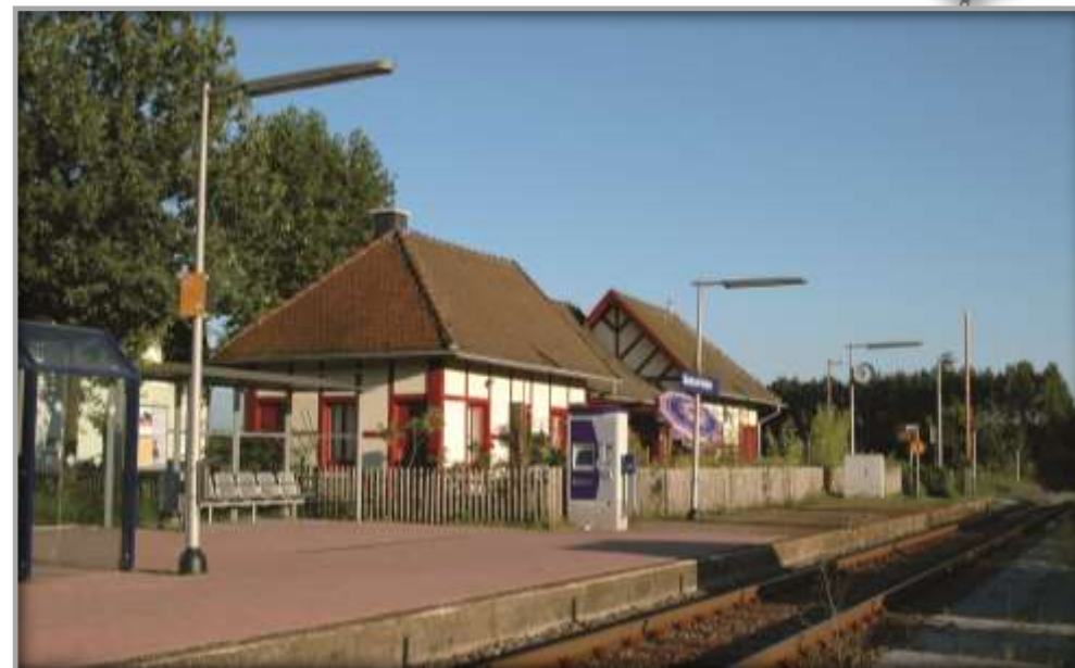
Empfangsgebäude nach der Sanierung
