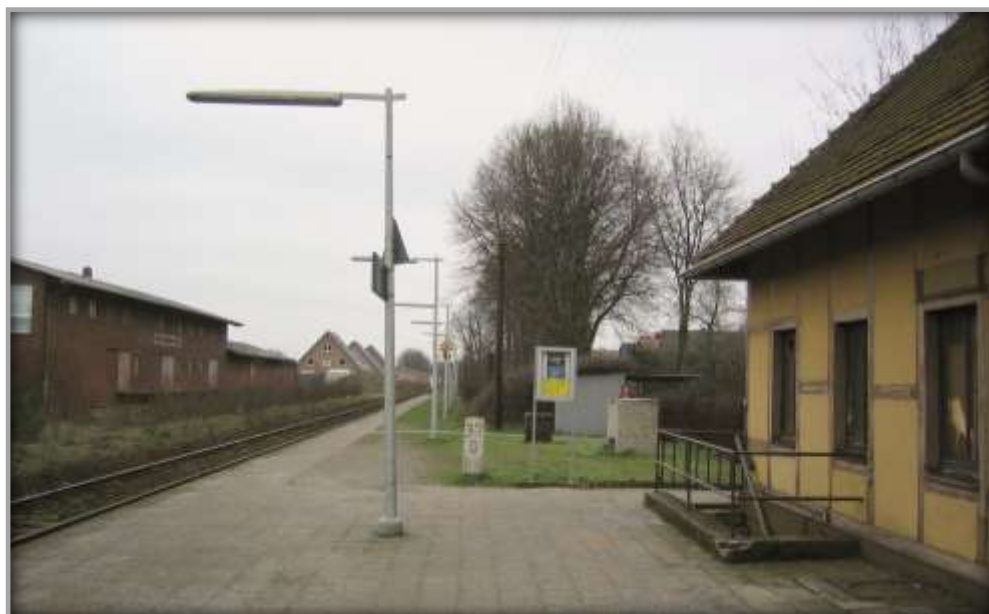
Bahnhofsumfeld vor der Sanierung
