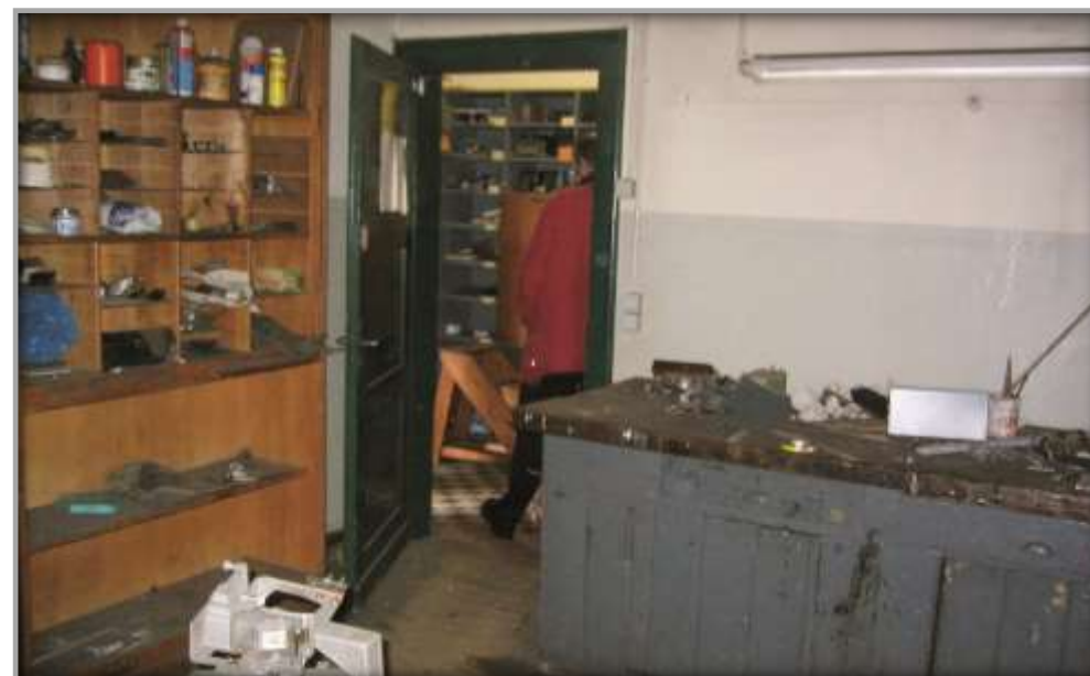
Innenansicht der Wertstatt vor der Sanierung
